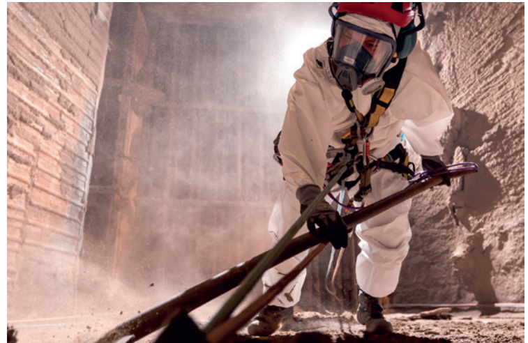
Industriekletterer arbeiten im Feuerraum einer Verbrennungsanlage
